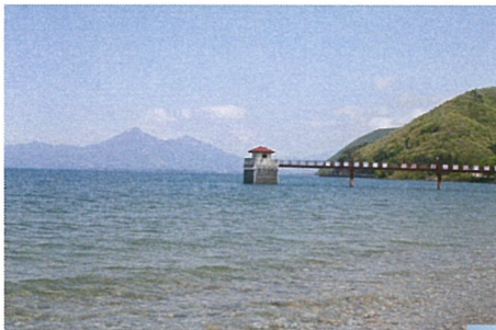
猪苗代湖浜路取水場
