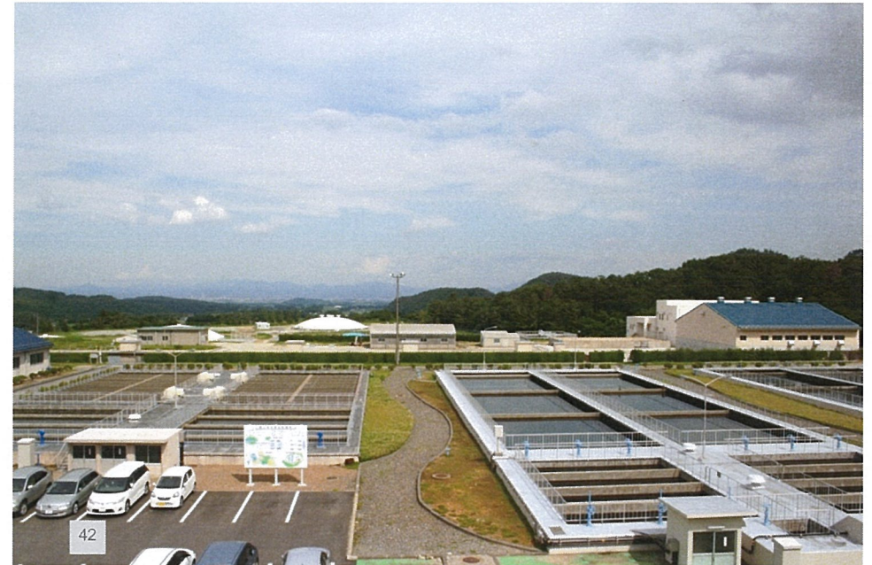
統合先の堀口浄水場
