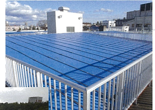
豊田浄水場 薬品沈でん池、薬品混和池 の覆蓋状況
