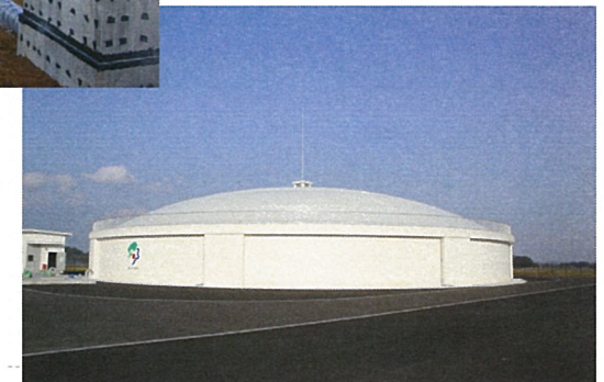
新たに整備した 多田野配水池 (容量10,000m 3 )
