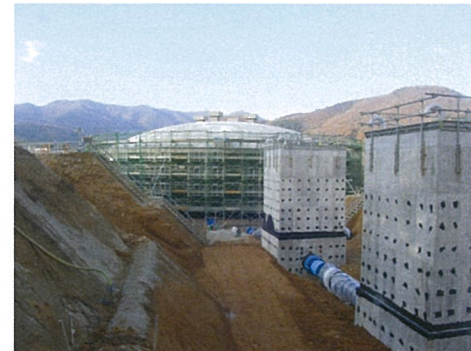
浄水池築造工事
