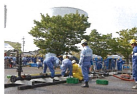
【応急復旧訓練】
