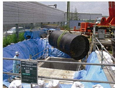
【春日井送水幹線の整備(共同溝への布設状況)】
