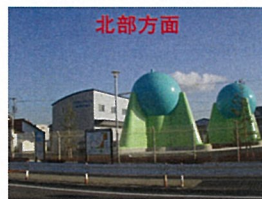
【比良西応急給水センター】
