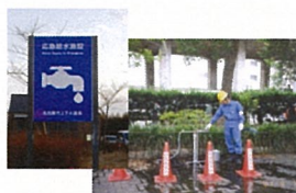
【応急給水施設】
