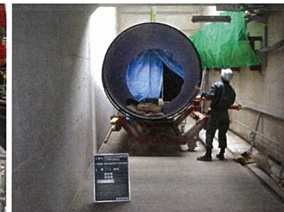
【春日井送水幹線の整備(共同溝への布設状況)】
