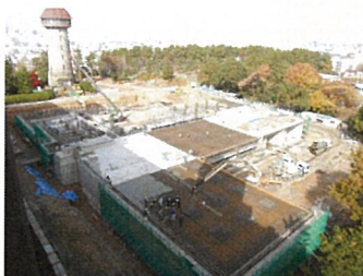
【東山配水場 2号配水池の更新・耐震化】
