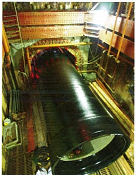
【犬山系導水路 A管の更新・耐震化】
