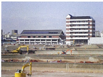
【鍋屋上野浄水場 緩速ろ過池の更新・耐震化】
