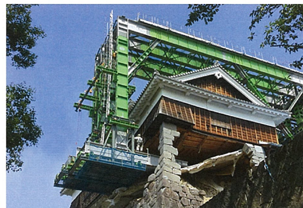
飯田丸五階櫓・大林組HPより
