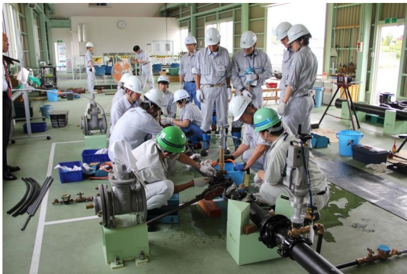
盛岡市上下水道局とのパートナーシップによる配管技能講習会
