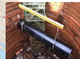
耐震管の運搬状況
