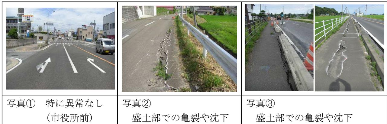
図 2.2.7 栗原市築館地区の道路上の被害状況
