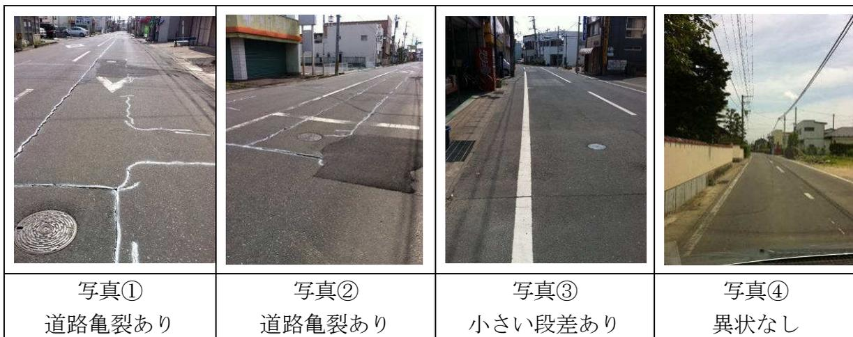
図 2.2.27 涌谷町役場周辺の道路上の被害状況
