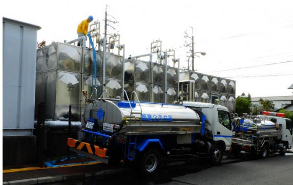
写真 13 病院の受水槽への応急給水状況
