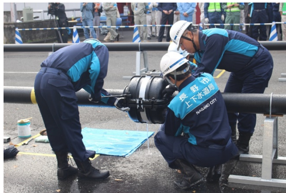
写真 16 カバージョイント設置状況
