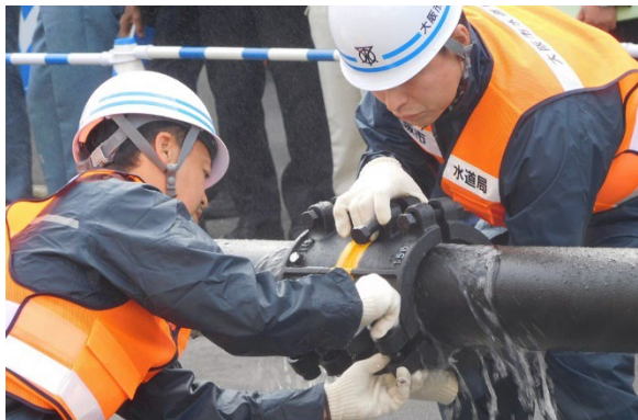
写真 15 漏水補修金具設置状況
