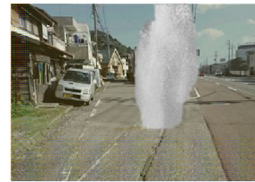
被害箇所：葵区籠上20番付近 配水本管 φ600 CIP
