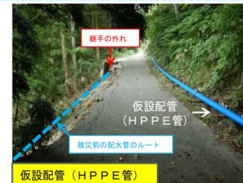
仮設配管(HPPE管)
