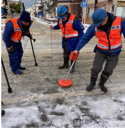
輪島市 雪中での漏水調査 (東京都)
