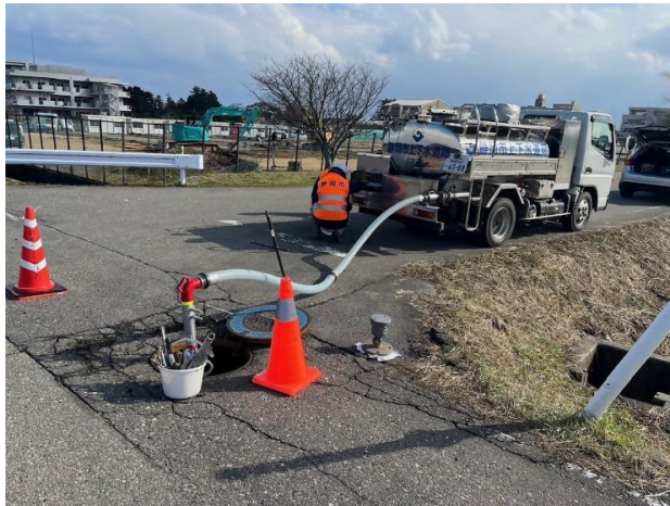
給水車による漏水調査(静岡市)
