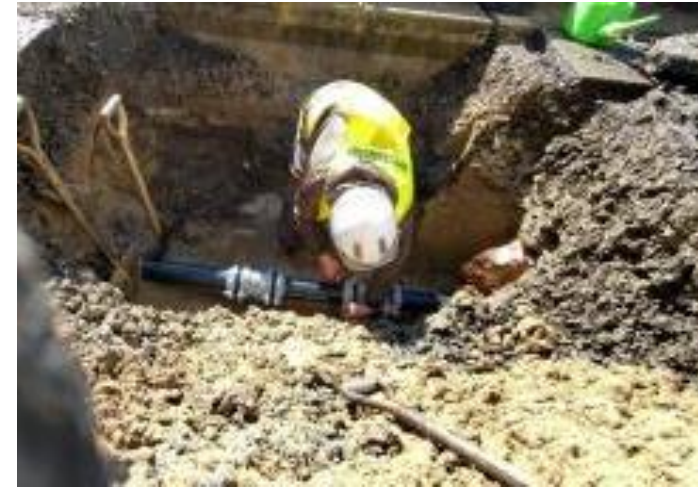
輪島市 管路修繕(高知市)
