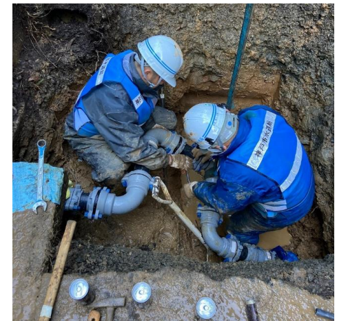
穴水町 管路修繕(神戸市)
