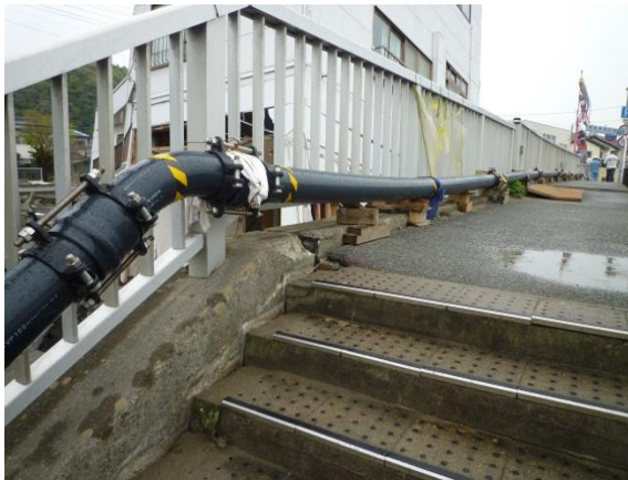
仮設配管(硬質塩化ビニル管)
