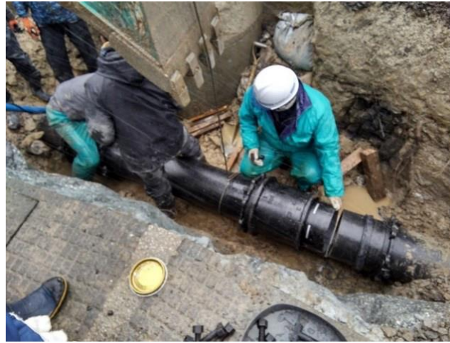
輪島市 送水管復旧工事(横浜市)
