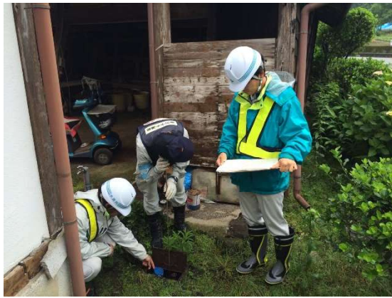
漏水調査作業の様子
