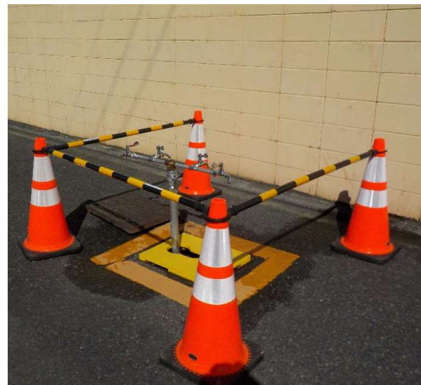
消火栓からの応急給水②
