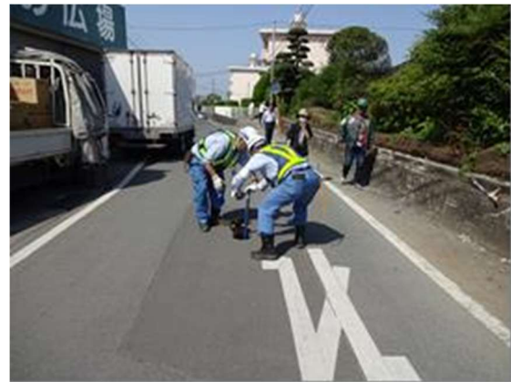
漏水調査作業（バルブ操作）の様子
