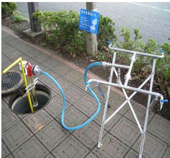
消火栓からの応急給水①
