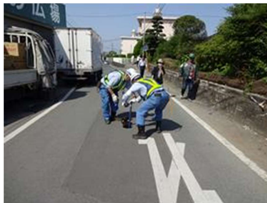
漏水調査作業（バルブ操作）の様子
