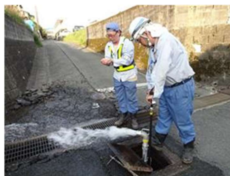
漏水調査作業（管洗浄）の様子
