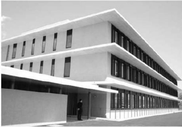
落成した高知市上下水道局庁舎の外観
