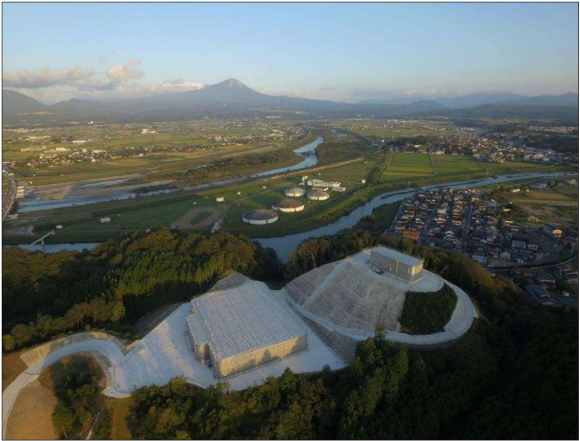
写真 1 南部配水池、中央配水池
