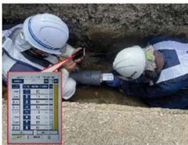
施工情報システムによる継手管理
