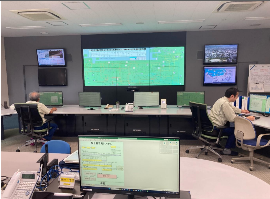
水管理センター 全景
