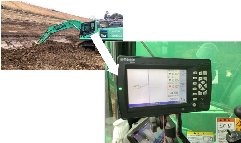
図-7 運転席モニター画面の3次元情報に従って操作
