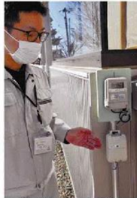
既存の検針メーターの下に新たに 取り付けられたスマートメーター
