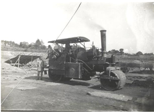
盛土を締め固める蒸気式転圧機（ローラー）
