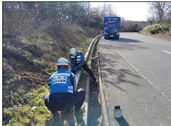
仮設配管工②
