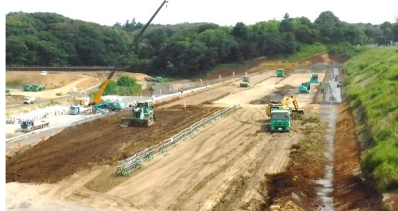
ICT重機を使用した強化盛土工事
