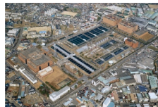
図-1 村野浄水場
