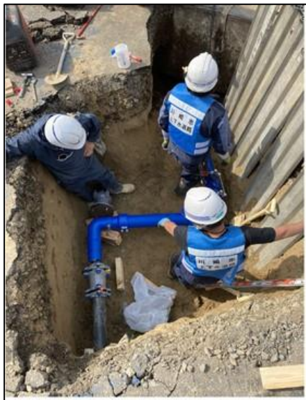
仮設配管工①
