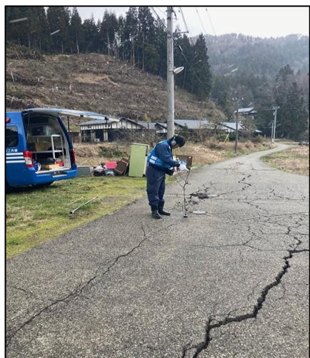
漏水調査①
