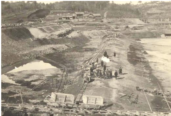
人力が中心の堤体築造工事
