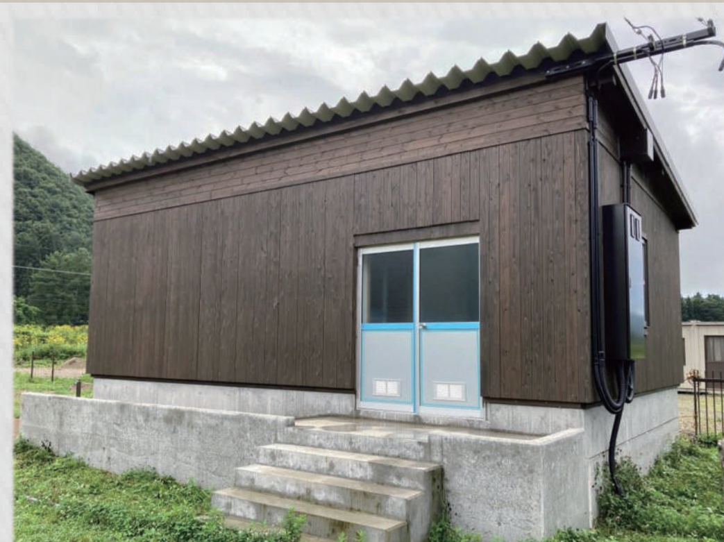
電気・薬品棟 (L8.2m × W5.4m × H3.0m)
