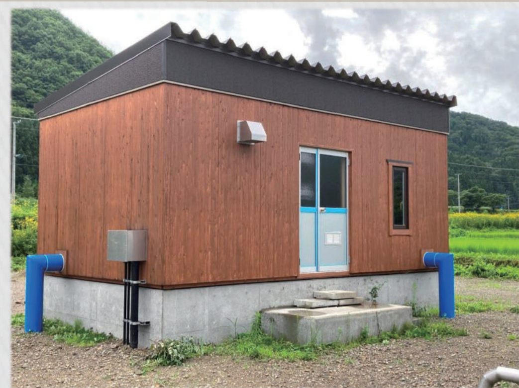
送水ポンプ棟 (L6.4m × W3.7m × H3.0m)
