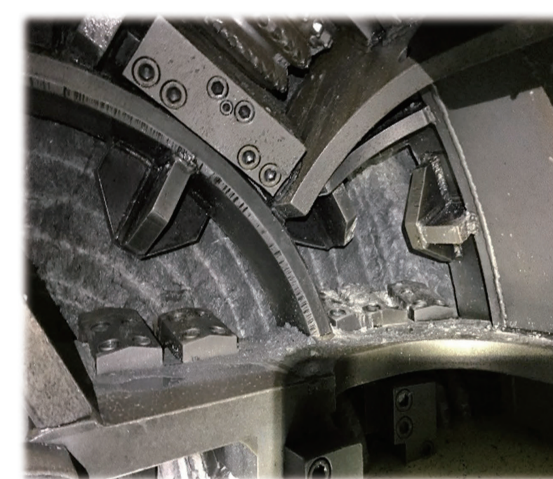
シールドマシン内から見る硬質岩盤層
