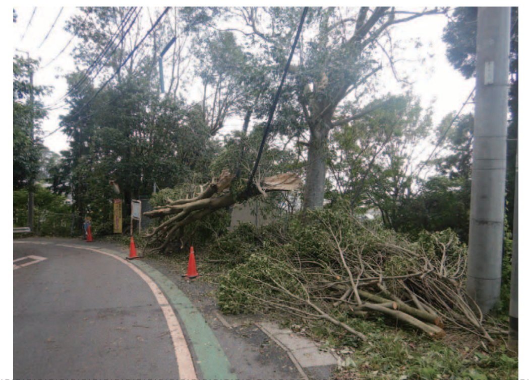
● 台風被害により停電した施設
