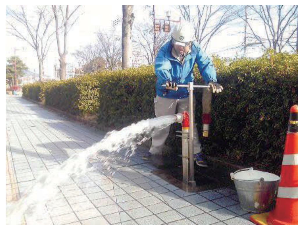
● 水道管洗浄作業の様子
