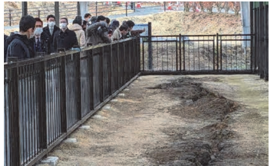
地震によって地表に現れた断層
