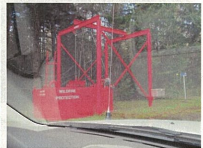
消火用水タンクに給水するタンク車への給水設備
