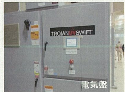
UV処理装置制御盤
