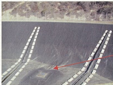
池内部を点検するためのハッチ
