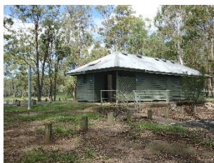
写真⑤ トイレ
