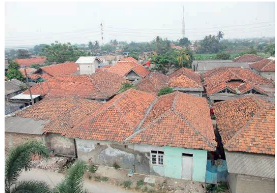
浄水場の隣はレンガ造りのスラム街
