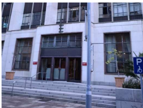
水需要管理戦略部が入居するビルの入口
