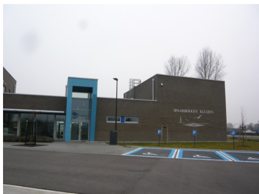
<Kluizen 浄水場管理棟>
