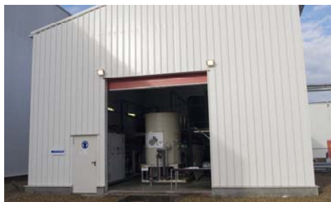
<工業用水処理施設外観>
