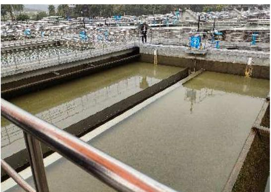
ろ過池に表洗管は見られない。洗浄工程を視察したが、洗浄は逆洗のみであった。当庁の浄水場ではクリプトスポリジウムへの対策のため、表洗との組み合わせやスローダウン、スロースタート洗浄などを取り入れているが、台湾においてはそこまでの対応はなされていないようである。
