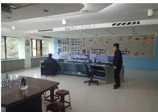
監視操作室ではグラフィックパネルや液晶によるディスプレイで浄水場内及びポンプ場等場外施設の監視操作が行われており、日本の浄水場とほとんど同じような設備構成であった。
