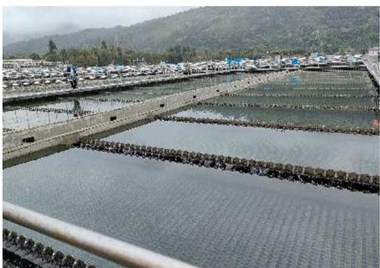
340万 $\text{m}^3$ /日という日本では見られない規模の巨大浄水場であり、敷地も広大なものであったが、横流式沈殿池には傾斜管が設置され、必要面積を小さくする工夫がみられた。
