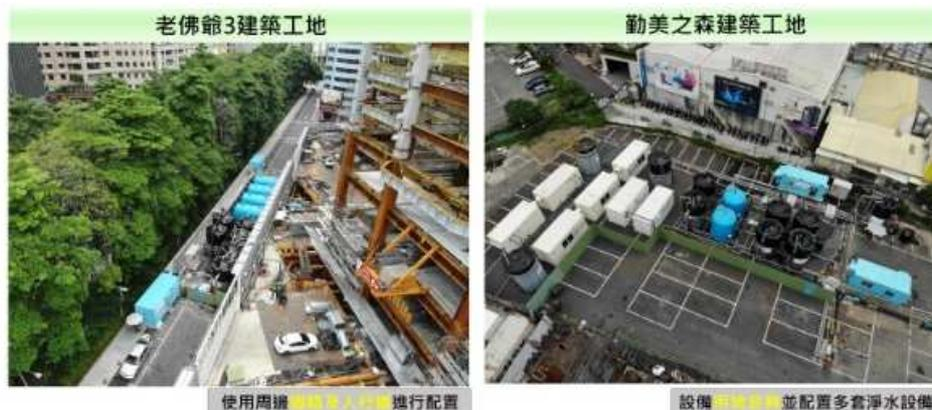
図5 建設工事現場で発生した地下水の活用（仮設プラント）
