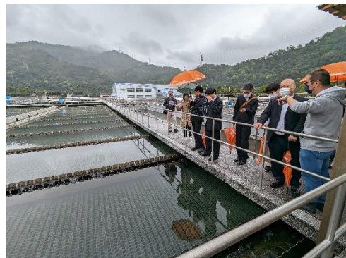
傾斜管式沈澱池
