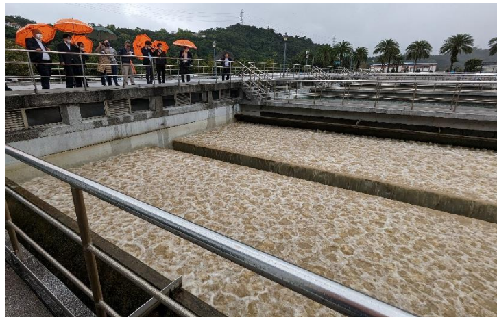
図 23. ろ過池逆洗の様子
