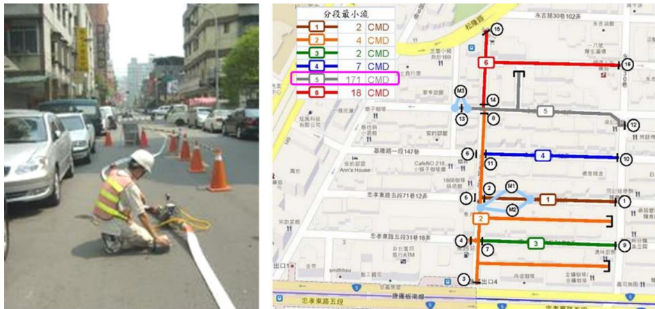
図 17. 漏水調査の様子
