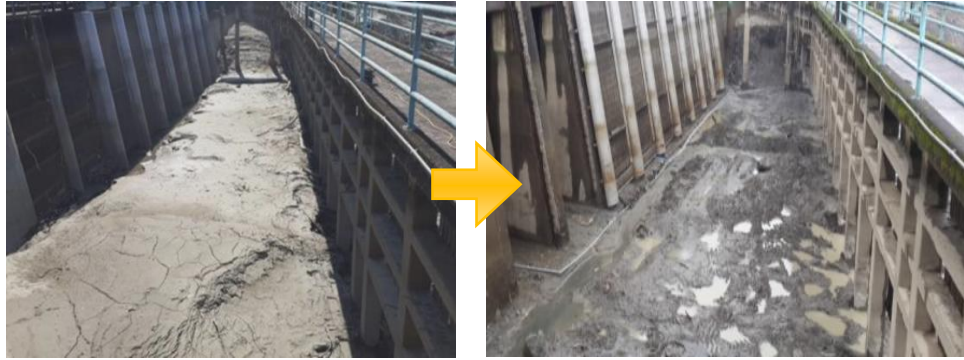
図 24. 重機による泥の除去（施設改造前）
