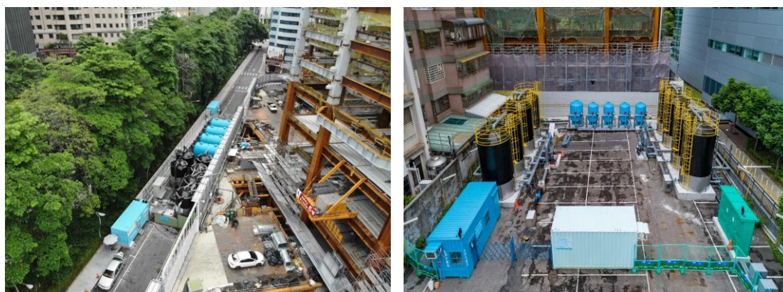
図7 緊急地下水くみ上げプロジェクトによって仮設されたプラントの一例
