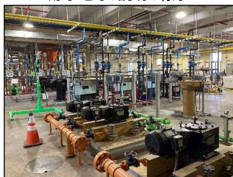
配管写真①
