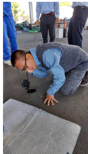
漏水調査実習
