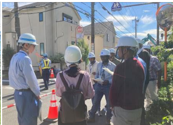
施工現場視察
