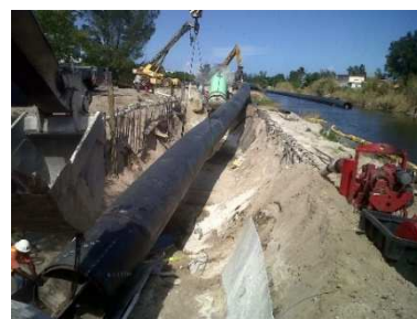
図-31 配水管工事の様子
