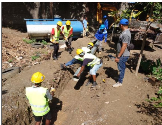
配水管整備工事の様子
