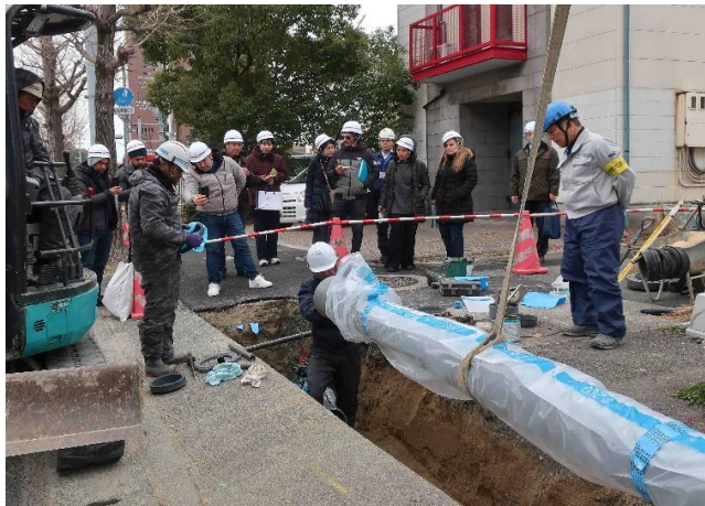
配水管工事現場の視察
