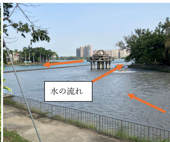
図4 澄清湖に設置された擁壁
