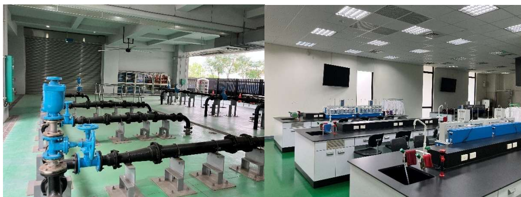
図6 研修施設（配管実務・水質試験）
