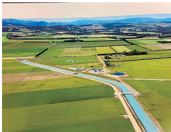
写真-14 建設された農業用水路
