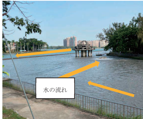
澄清湖の放水路付近
