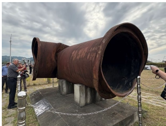
写真2.5.4 断層のずれにより変形した管
