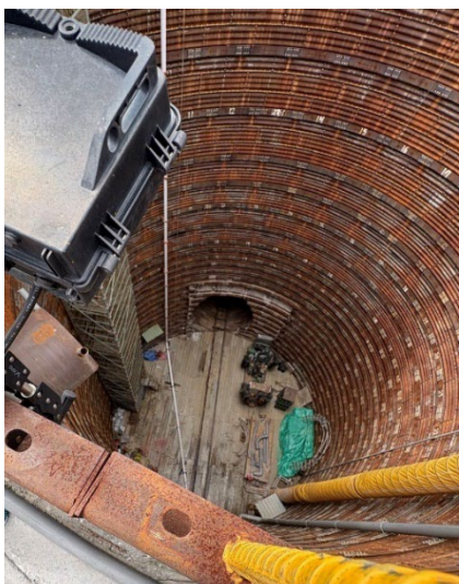
写真2.5.1 地下深くに位置しているシールドトンネル
