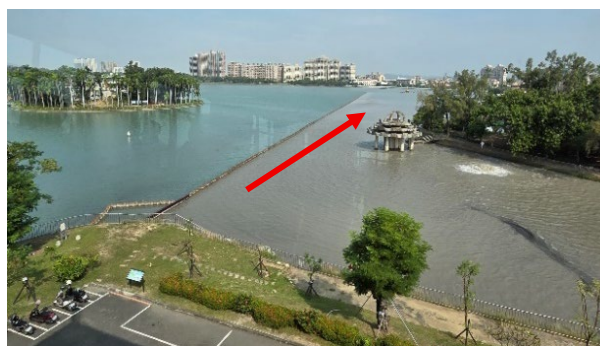
写真2.1.2 着水地点(写真右側)から導流壁(写真中央)を迂回させ濁度を落としている(矢印は水の流れ)
