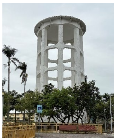
写真2.2.5 日本統治時代に作られた給水塔を修復し保存している
