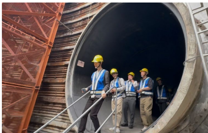
写真2.5.5 布設中の導水管（φ3500mm）内を通る参加者
