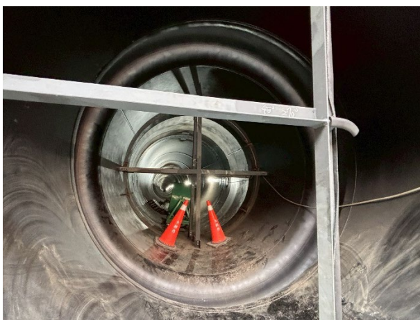
写真2.5.7 連絡導水管（φ3000mm）に採用されているSPF
