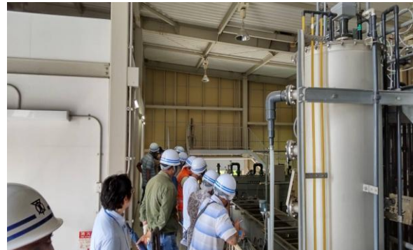
浄水処理に関する実習
