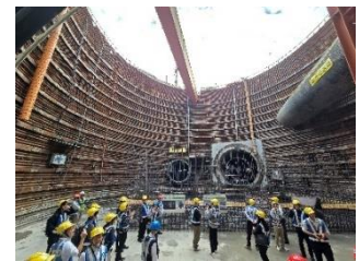
図 5-32 大甲溪送水管 第一工区
