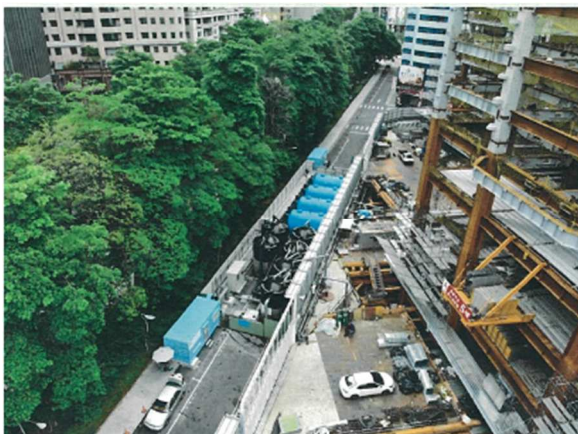
写真-2 渇水時に工事現場の地下水を利用した事例（台中市）
