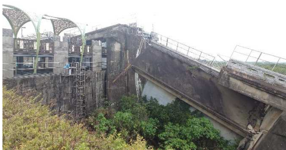
写真-12 石岡ダムの堤体
