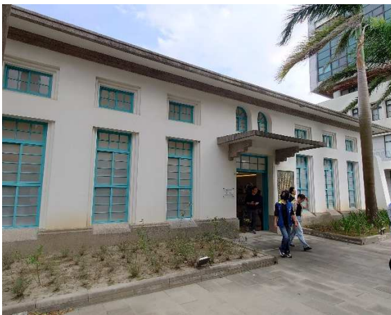
写真-7 日本統治時代に建てられたポンプ室
