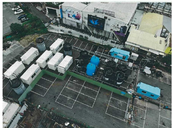
写真-2 渇水時に工事現場の地下水を利用した事例（台中市）
