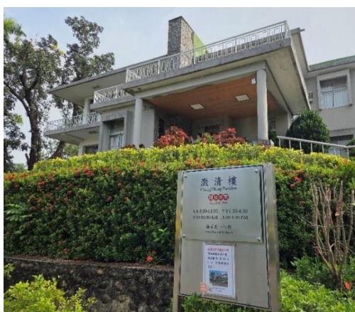
写真-7 激清樓の外観
