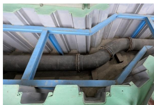
写真-16 ピット内操作研修設備
