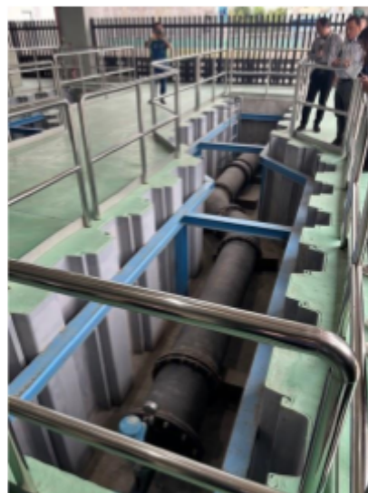
図15 配管接合 教習所
