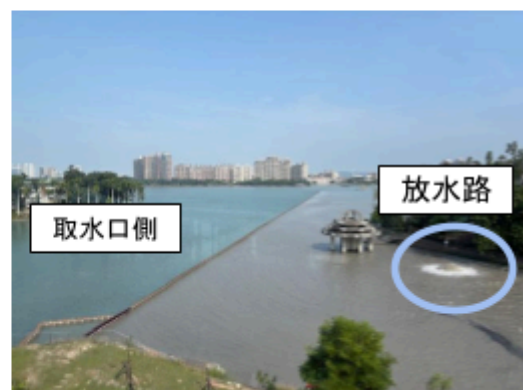
図12 澄清湖 放水路付近
