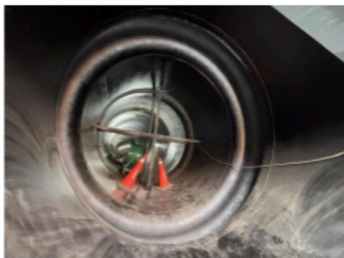
図22 大甲溪輸水管 SPF工法 施工箇所
