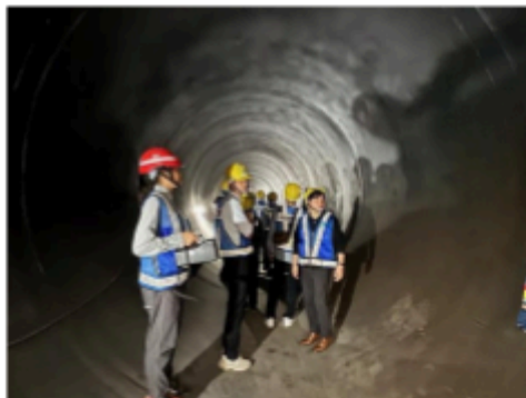
図21 WSP推進工法 管路内の見学状況
