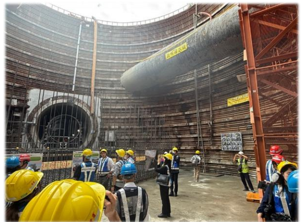
写真12 石岡ダムの大口徑鋼管施工現場 (4) バンケット（宴会）
