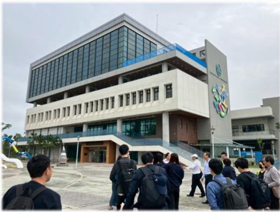
写真6 台湾水道公社研修センター
