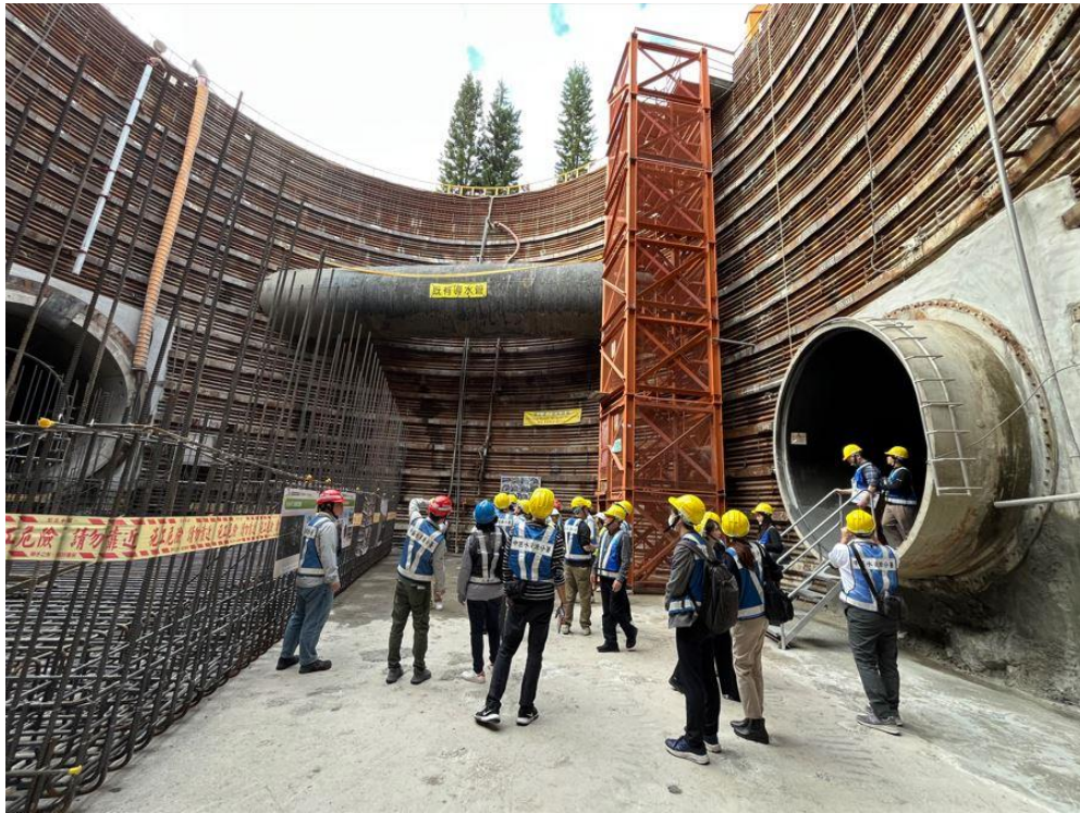
図 18. 大口径導水管の工事現場
