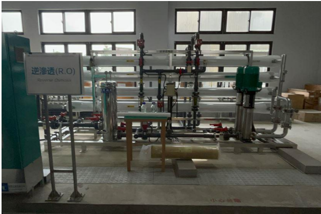
図 8. 逆浸透 (R.O) 装置
