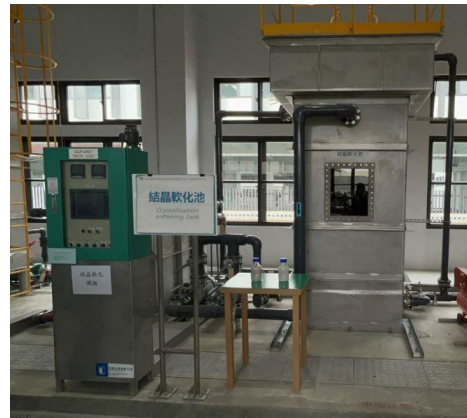
図 9. 結晶軟化装置
