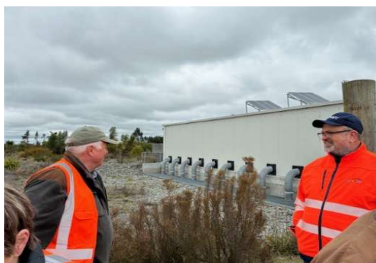
(写真-21 ポンプ場視察)
