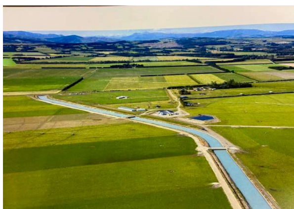
(写真-15 建設された農業用水路)
