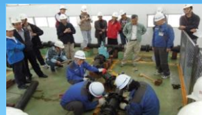
百潭浄水場内での配管・接合講習会
